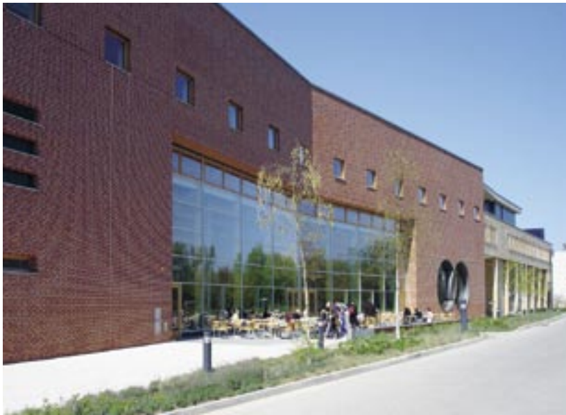
Das Gräfin-Dönhoff-Gebäude (Mensa und Hörsäle)
