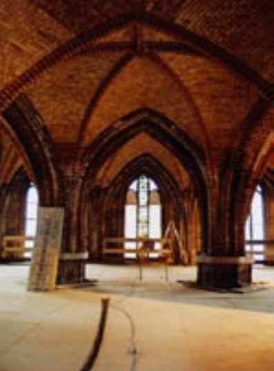
Ukończona odbudowa sklepień prezbiterium
