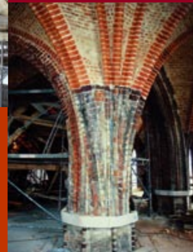
Prace konserwatorskie przy filarach obejścia prezbiterium
