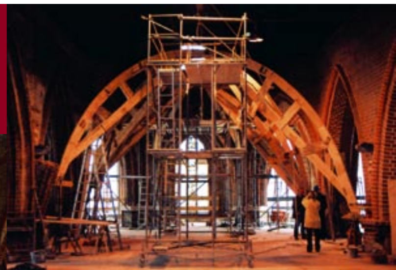
Konstrukcja pomocnicza dla odbudowy sklepień na górnym poziomie i rusztowania
