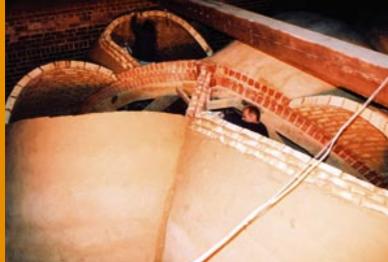
Murowanie pól sklepiennych
