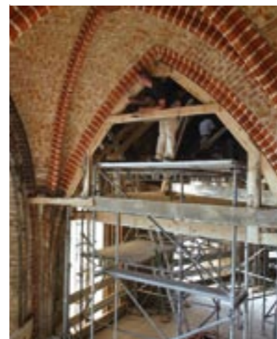
Prace konserwatorskie przy sklepieniu obejścia chóru (fot.: Winfried Mausolf)
