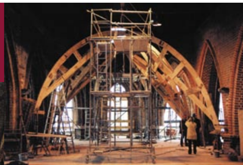
Errichtung der Lehrbögen auf der 12 m hohen Arbeitsebene
