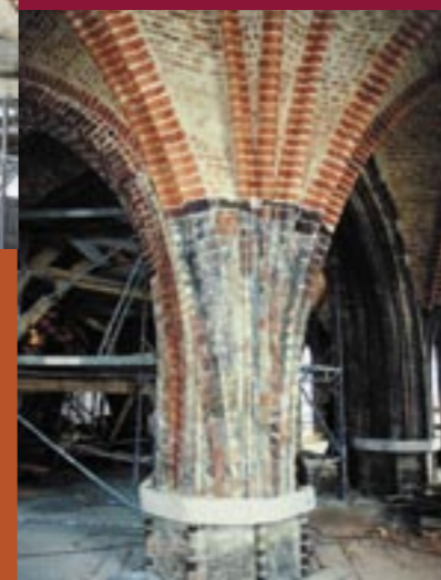
Restaurierungsarbeiten an den Pfeilern des Chorumgangsgewölbes
