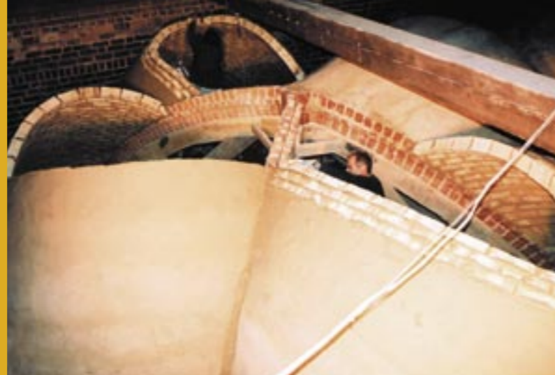
Mauern der Gewölbekappen
