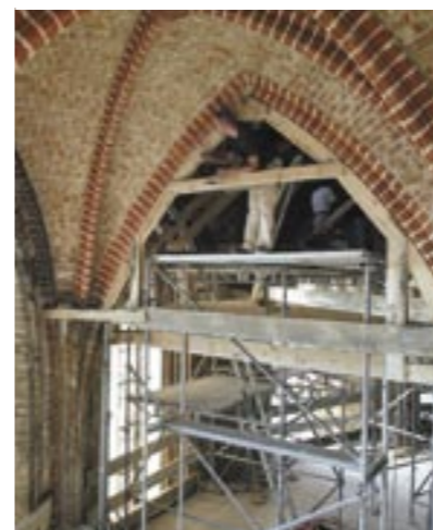
Restaurierungsarbeiten am Chorumgangsgewölbe (Foto: Winfried Mausolf)
